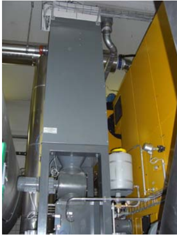
Der Filterzyklon für das „Pelletvac“-System basiert auf der bewährten ESTA-Absaugtechnologie
