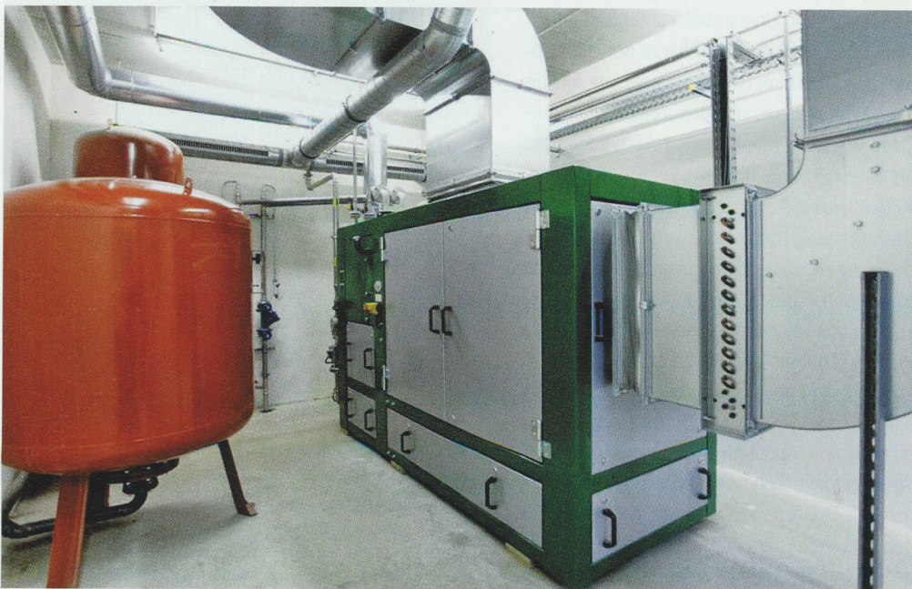
Wirksam gegen Körperschall und Schallemissionen: Das Spektrum der Gegenmaßnahmen von 2G reicht von Motorschalldämmkapseln bis zum neuen Super Silent Container High Line.
