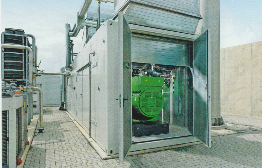
Auch ungewöhnliche Aufstellungsorte wie Gebäudedächer oder die Einbringung in Parkhäuser sind dank ausgeklügelter Container-Lösungen möglich.
