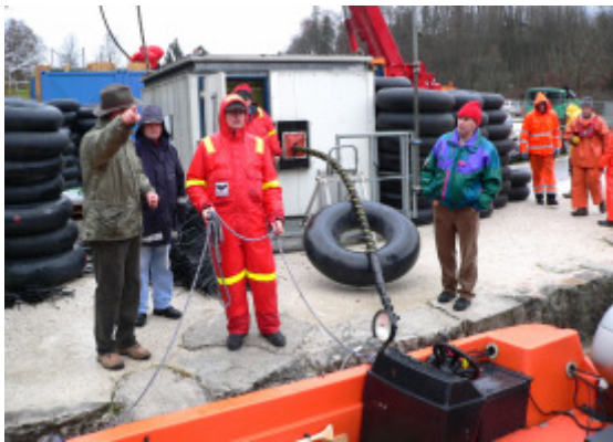
Bild 2: Startbereit zur schwimmenden Verlegung (Foto: Franz Heger)
