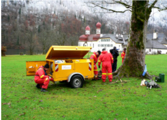
Bild 1: Vorbereitungsarbeiten (Bild: Franz Heger)
