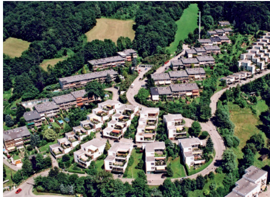
Der Energiepark Plesching bei Linz beherbergt das erste Smart-Metering Pilotprojekt der LINZ STROM in Kooperation mit ubitronix system solutions
