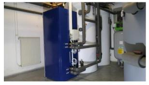
Schlanke Bauform, starke Wirkung: Die eXergiemaschine (blaues Gerät) hebt das Temperaturniveau so an, dass mit der Abwärme der Kältetechnik sogar Reinigungswasser bereitet werden kann. (Bild: varmeco)
