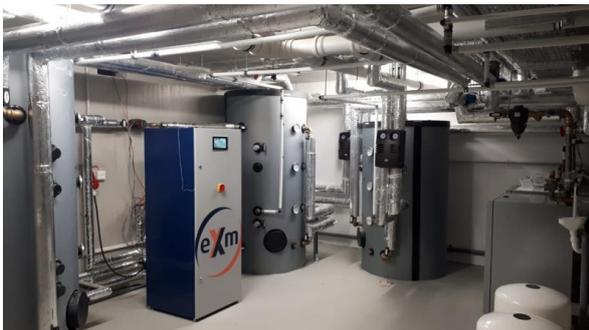
Dank der nachgeschalteten eXergiemaschine (eXm) lässt sich die Wärmepumpe des Wohngebäudes dazu nutzen, warmes Wasser bei ca. 60 °C bereitzustellen. (Bild: varmeco)
