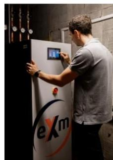
Die eXergiemaschine nutzt die von den Hybrid-Solarmodulen im Niedertemperaturspeicher bereitgestellte Energie, hebt das Temperaturniveau an und lädt den Hochtemperaturspeicher für die Warmwasserbereitung auf. (Bild: Hotel Lisetta)
