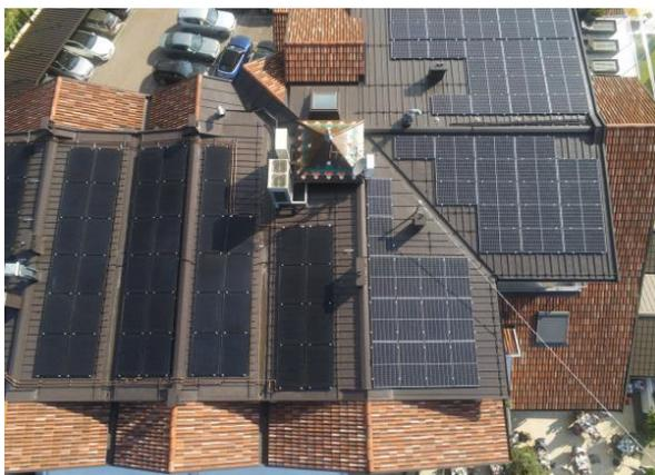
Dank der nachgeschalteten eXergiemaschine (eXm) lässt sich die Wärme der Hybridmodule effizient nutzen. Gleichzeitig kühlt die eXm die Photovoltaik-Elemente der Hybrid-Panels und steigert so deren Wirkungsgrad. (Bild: Hotel Lisetta)
