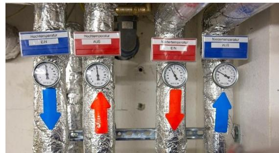
Die eXergiemaschine wird über vier Anschlüsse mit dem Speichersystem verbunden (Bild: varmeco)
