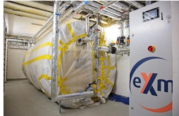
Die eXergiemaschine nimmt Solarwärme aus diesem Speicher und hebt die Temperatur auf ein geeignetes Niveau für eine hygienische Warmwasserbereitung und für Hochtemperatur-Heizkreise (Bild: varmeco)
