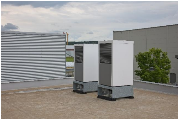
Wärmepumpen haben das alte BHKW abgelöst
