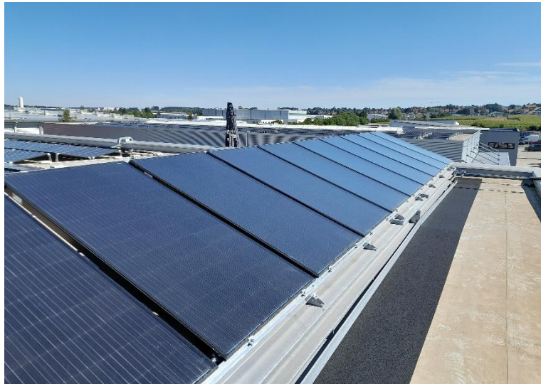
Die neuen PVT-Module auf dem Verwaltungsgebäude der varmeco
