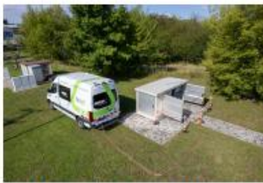
BAUR titron in action_1_(c) BAUR GmbH.jpg
