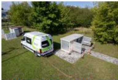
BAUR titron in action_1_(c) BAUR GmbH.jpg
