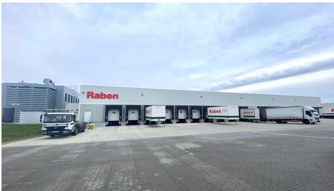
Die Niederlassung in Gera mit einem 18.000 m 2 großem Logistiklager.
