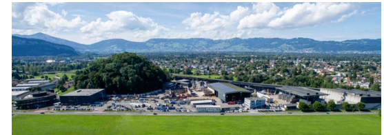
Der Hauptsitz der Loacker Recycling GmbH in Götzis
