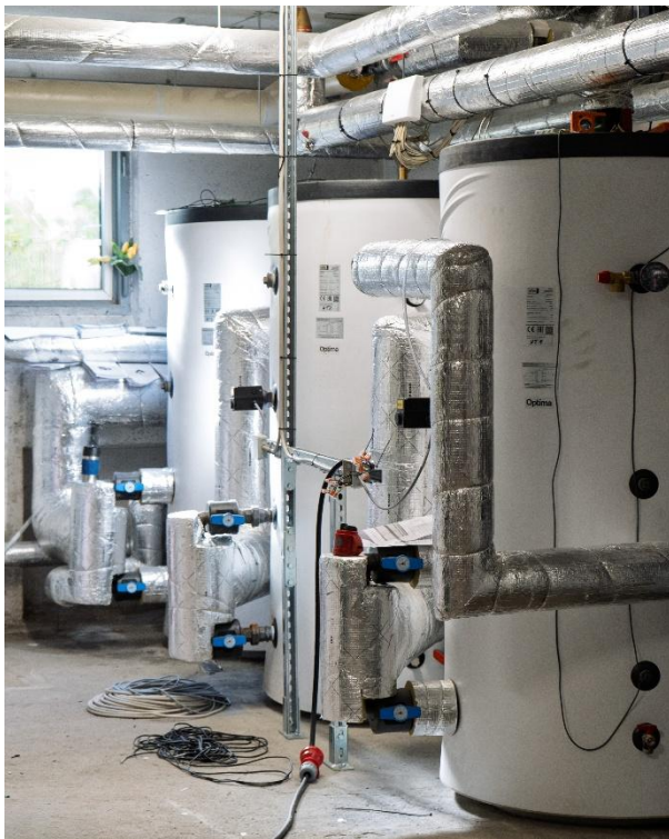
Jedes der vier Gebäude hat eine eigene Heizzentrale. Hier die Energiespeicher, die von den Wärmepumpen und von der eXergiemaschine (eXm) geladen werden
